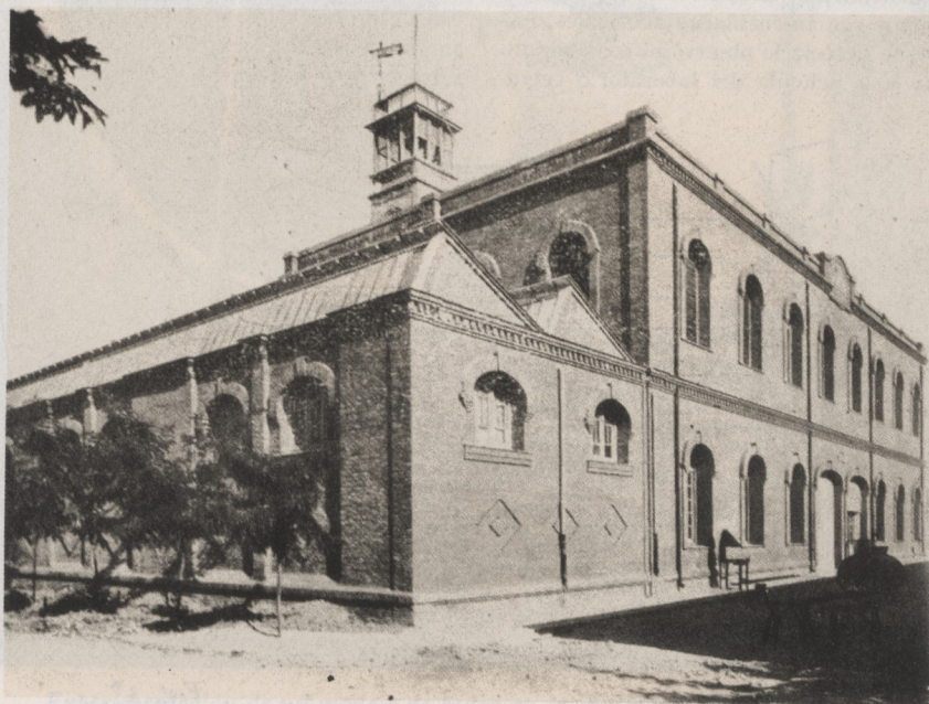
Vista exterior del Laboratorio Aerodinámico.
